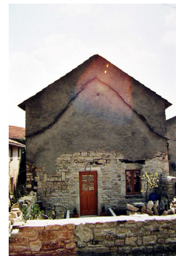
vestiges d'une couverture en chaume
