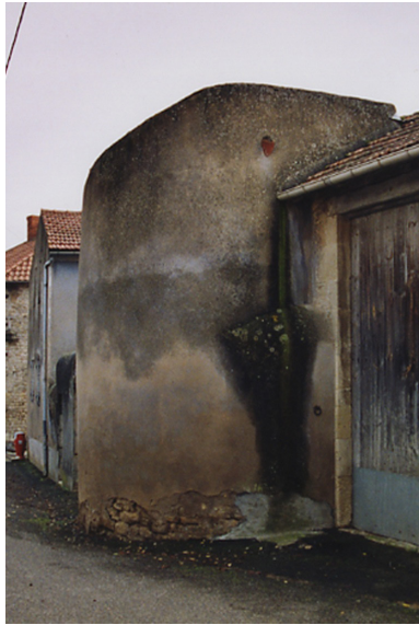
la tour n°1 - avant et après restauration
