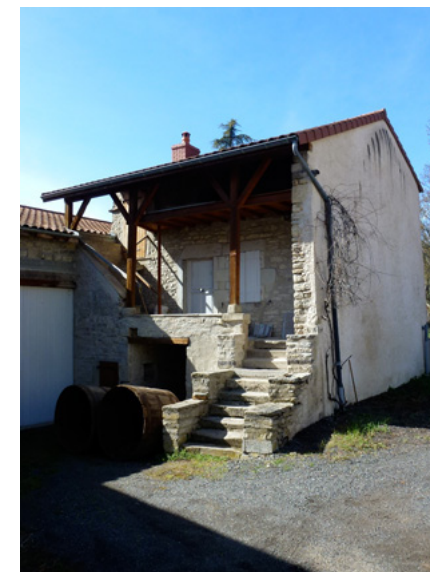
une rénovation respectueuse de l'architecture traditionnelle excepté pour la rive, partie pourtant la plus perceptible du toit
