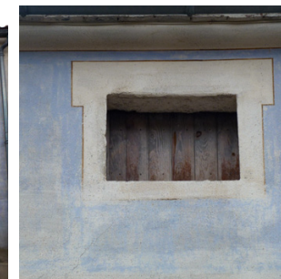
exemples anciens de badigeon au lait de chaux et interprétation récente
