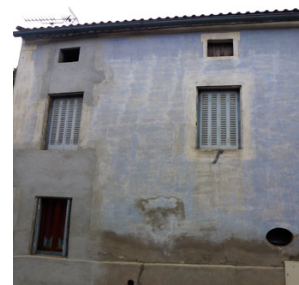
exemples anciens de badigeon au lait de chaux et interprétation récente
