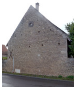
A Bicon comme à Artonne, des murs, construits en petits moellons de calcaire soigneusement assisés et jointoyés, constituent une des grandes caractéristiques de la commune. Ils témoignent d'un juste équilibre entre le souci d'économie, une volonté esthétique et l'art du maçon et constituent un patrimoine fragile qui doit être respecté et conservé.
