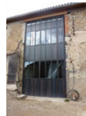
Une grande ouverture utilitaire transformée par une menuiserie contemporaine intégrée aux proportions de la baie
