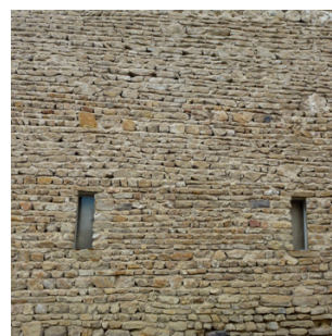
A Bicon comme à Artonne, des murs, construits en petits moellons de calcaire soigneusement assisés et jointoyés, constituent une des grandes caractéristiques de la commune. Ils témoignent d'un juste équilibre entre le souci d'économie, une volonté esthétique et l'art du maçon et constituent un patrimoine fragile qui doit être respecté et conservé.
