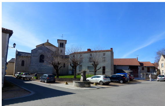
la place Saint-Jean à l'issue des travaux de requalification
