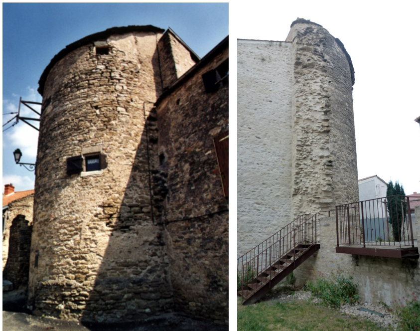
l' «Antique tour» et arrachements du rempart les principaux vestiges perceptibles de la première enceinte
