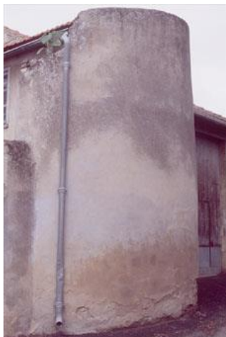
Tour boulevard des Ussels
